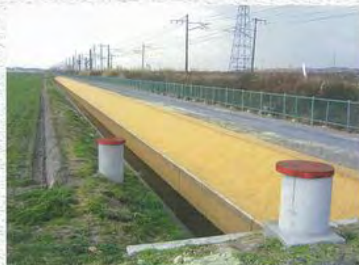
宮城県 遠田郡 田尻大沢地内
