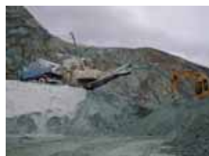
土質改良機で生石灰を添加 高度な混合・解砕・細粒化
