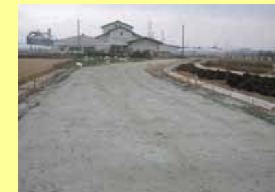
路床転圧仕上がり面
