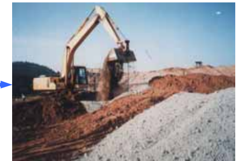
築堤盛土材 として
