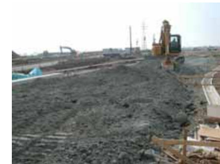
路体・路床盛土材 として
